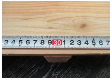
5 上板30cmに印を付け、上板5枚の真ん中と桁を釘で止めます。止めて裏返して下さい。(お好みで両端以外は釘で止めなくても大丈夫です)
