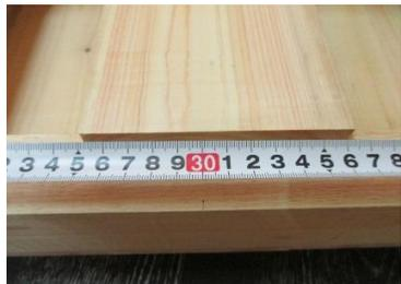
8 桁の30cmの所に印をつけて上板の真ん中と30cmの所で釘で止めて下さい。
