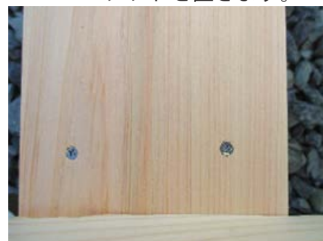
13 中心部以外のパレットをビス (40mm) で止めて下さい。
