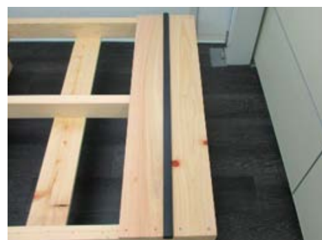
15 エコバーを使うと、効率よく約 2.5cm の間隔をとることができます。
