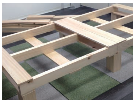
14 2枚のパレットの各両端に上板を合わせ、ビス (40mm) で止めて下さい。
