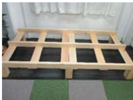
10 2つのパレットを脚材の上に置きます。
