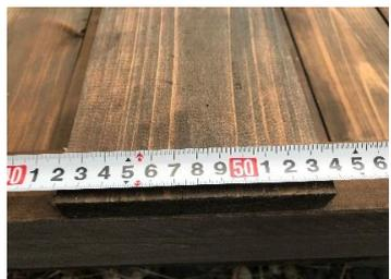
10 桁の48cmの所に印をつけて上板の真ん中と48cmの所で釘で止めて下さい。
